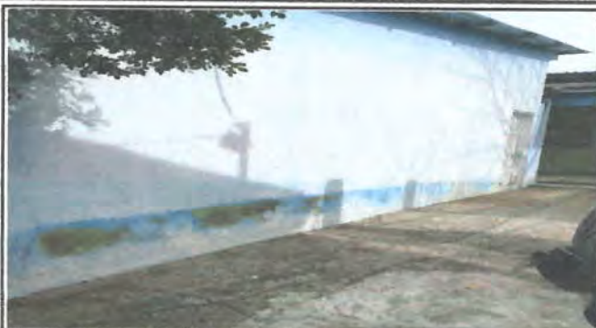
Foto1: PINTURA EN MUROS EXTERIORES E INTERIORES
