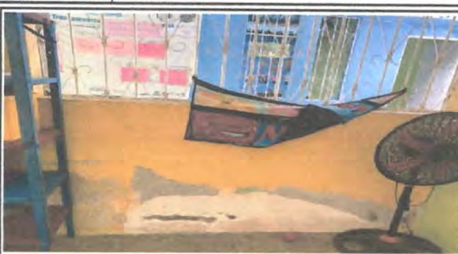
Foto 2: REPELLO Y CERNIDO EN PAREDES
