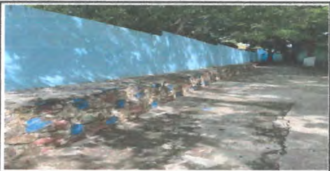
Foto 5: LOSA EN PATIO
