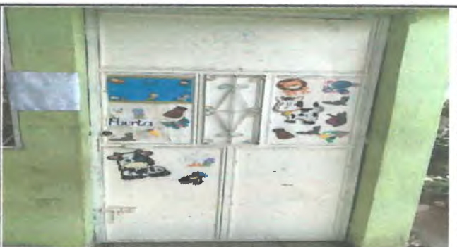
Foto 4: MANTENIMIENTO A PUERTA
