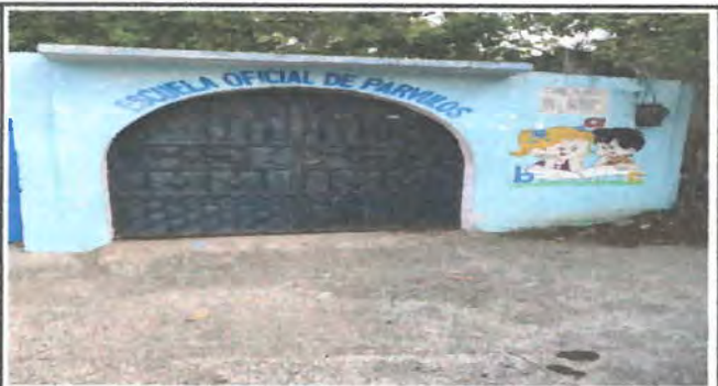
Foto 3: MANTENIMIENTO A PORTON
